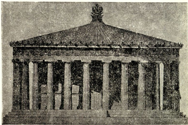
Θόλος τῆς Ἐπιδαύρου (ἀναπαράστασις) Οἱ ἐξωτερικοὶ κίονες ἦσαν δωρικοῦ ρυθμοῦ, ἀλλ' ἡ ἐσωτερικὴ κιονοστοιχία ἦτο κορινθιακοῦ
